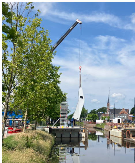
Plaatsing onderdeel Drouwenermondsebrug
