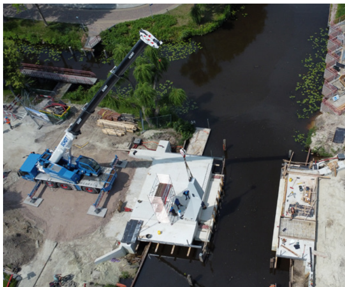
De nieuwe brug krijgt vorm.
